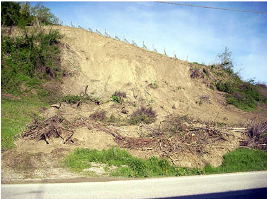
*Frana di saturazione e fluidificazione della copertura eluvio-colluviale presso Diano d'Alba (CN), lungo la SP130. Frane di questo tipo sono risultate molto diffuse: in certi settori, lungo le strade, ne sono state rilevate oltre 10 a chilometro lineare (f. F. Luino, CNR-IRPI).*
