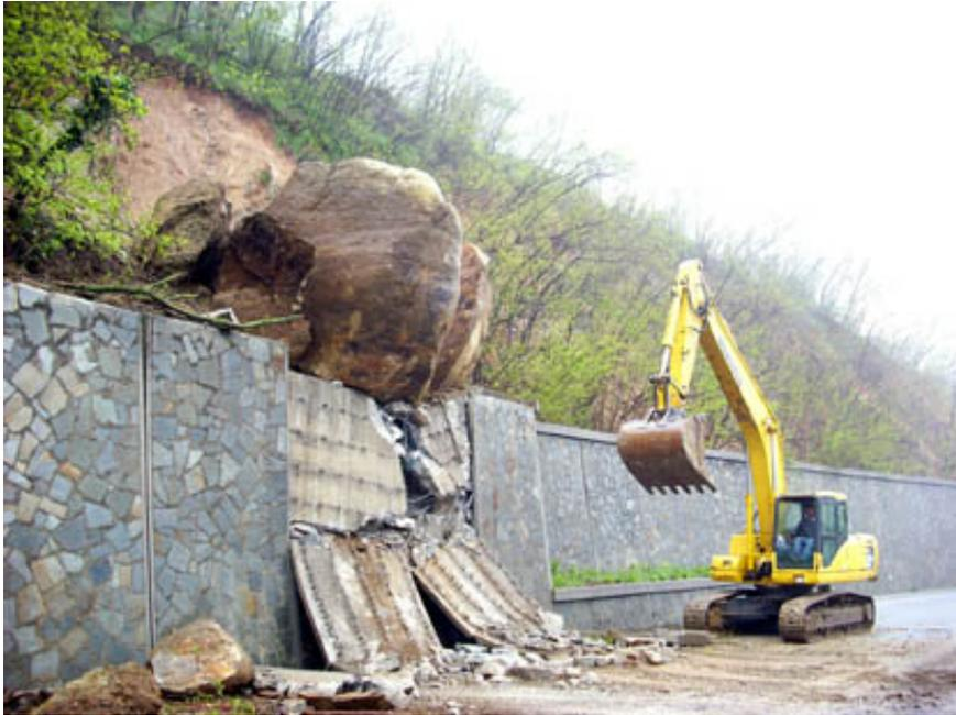
*Ceva, frazione Rocchini (CN). Ore 8 del 28 aprile 2009. Masso lapideo di oltre 100 m<sup>3</sup>, con una traslazione di solo una decina di metri, ha fortemente lesionato il muro di contenimento della SS28 (f. F. Luino, CNR-IRPI).*
