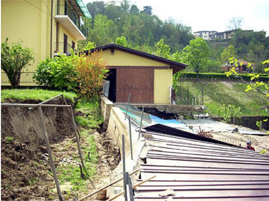
*Abitazione di Monforte d'Alba (CN) a mezza costa su un versante in frana. Il cortile della casa ha subito uno sprofondamento di 1,80 m lesionando i muri di contenimento in cemento armato (f. F. Luino, CNR-IRPI).*
