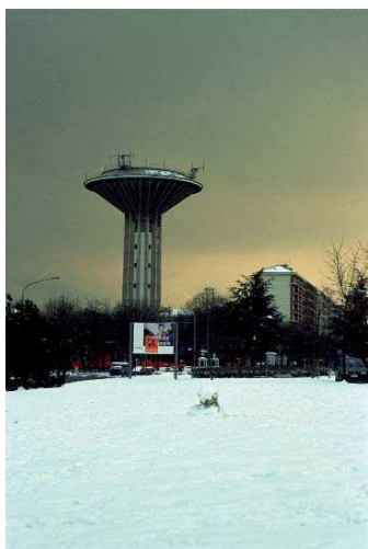
Neve di periferia il 28.02.2001: il serbatoio SMAT di Via Gianfrancesco Re, nei cui pressi la Società Meteorologica Subalpina ebbe sede dal 1997 al 2005 (f. L. Mercalli).
